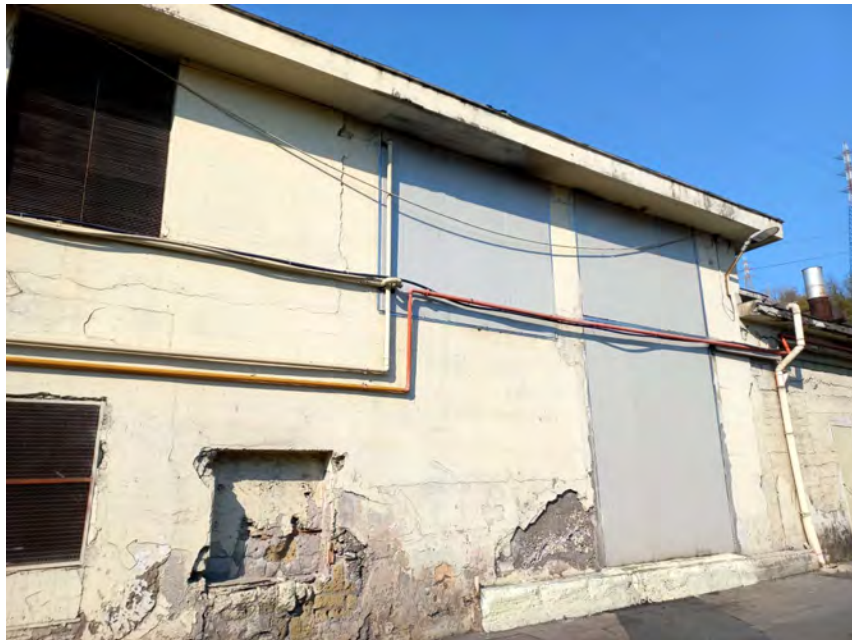
Fig.4 - opere di bonifica acustica relative alle aperture esterne della sala compressori
