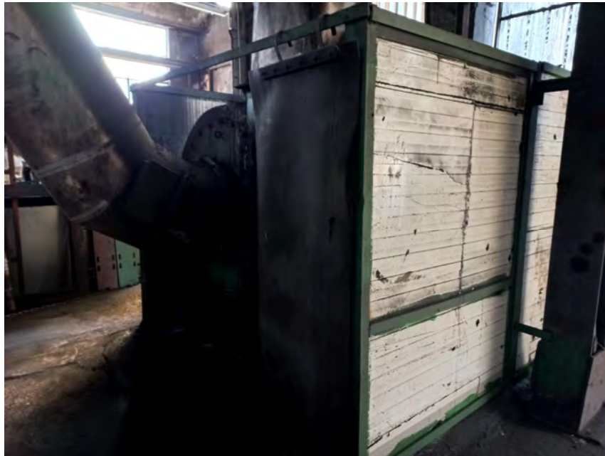
Fig.5 - opere di bonifica acustica interne alla sala compressori
