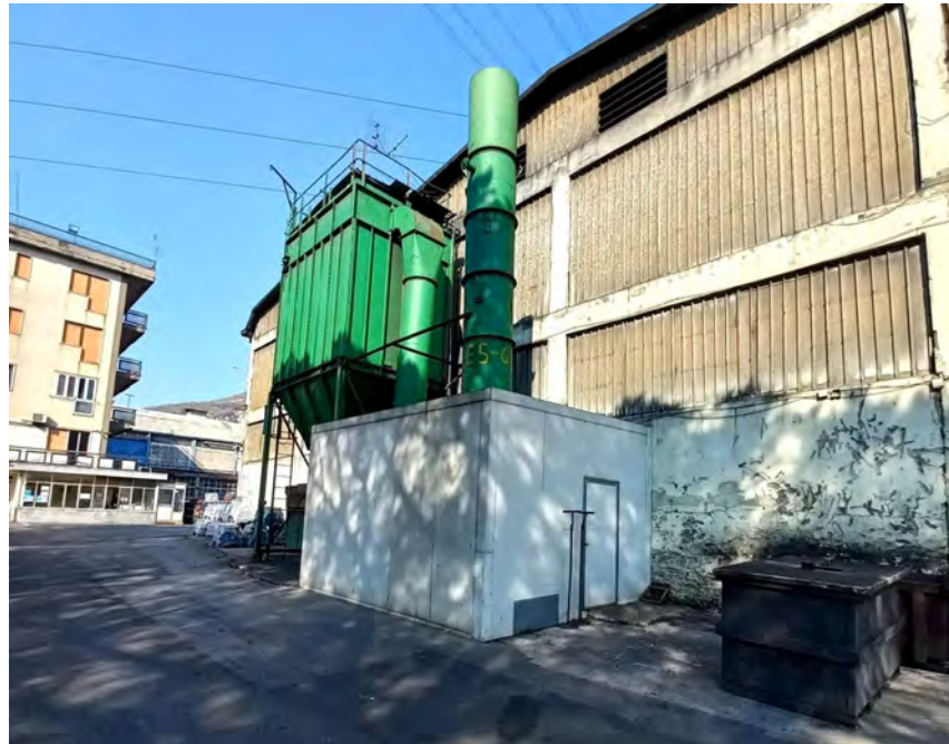
Fig.1 - opere di bonifica acustica relative al camino E5-6
