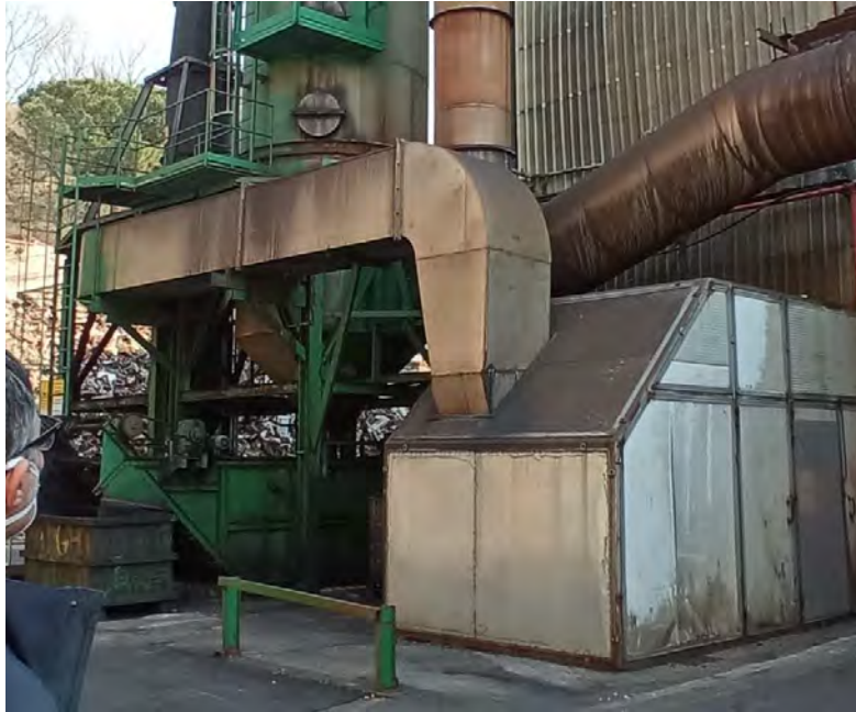
Fig.7 - opere di bonifica acustica relative al camino E3
