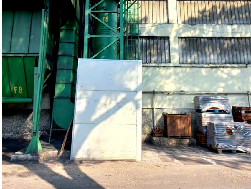
Fig.3 - opere di bonifica acustica relative al camino E8
