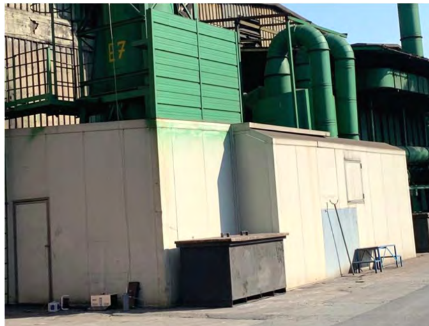
Fig.2 - opere di bonifica acustica relative al camino E7
