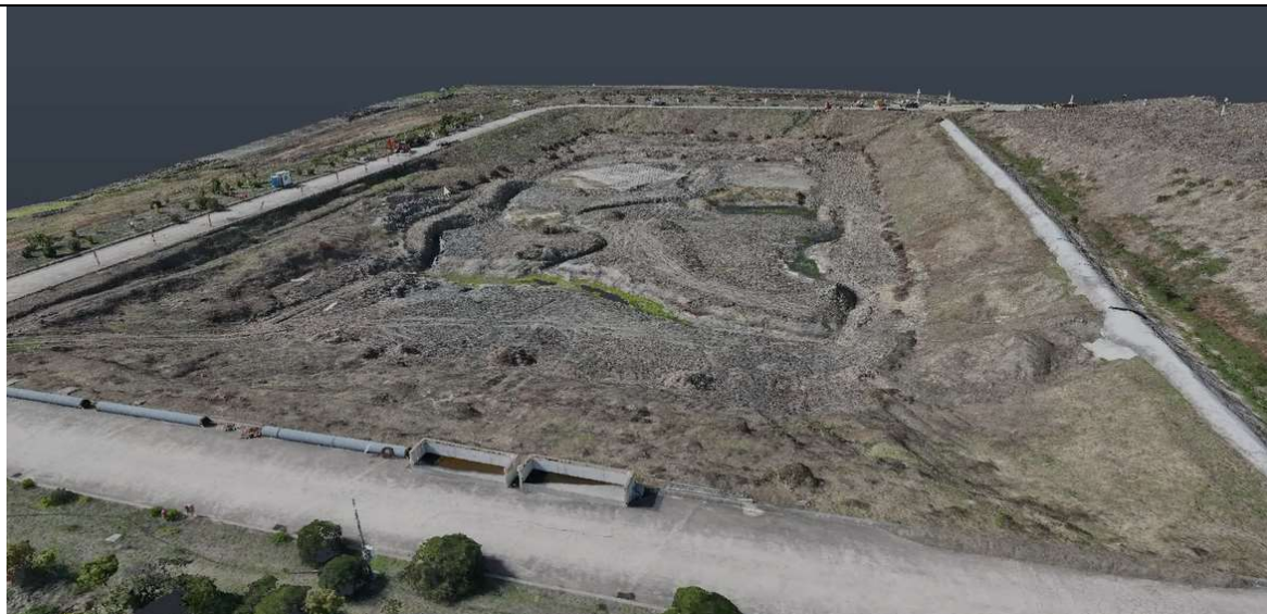
Fig. 3: vista della vasca dal lato Sud-Est
