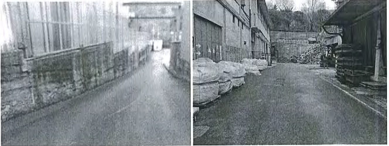
Foto 8-9_ Piazzali Lato Autostrada oggetto di ripavimentazione
