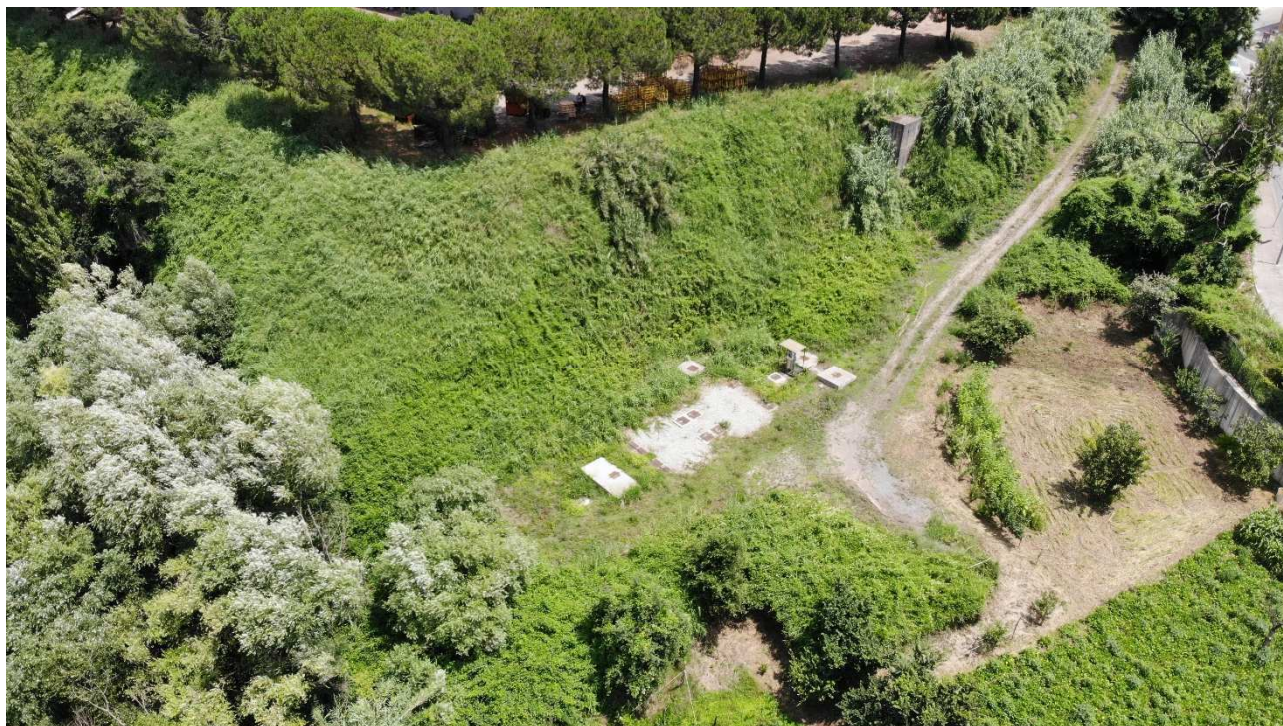
Figura 6 - Foto aerea esistente impianto di trattamento acque di prima pioggia – Direzione NORD – EST
