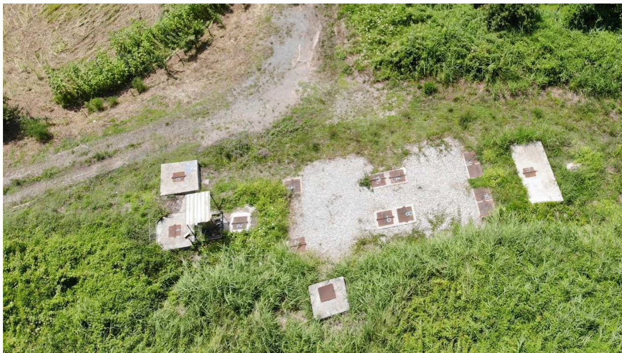
Figura 7 - Foto aerea esistente impianto di trattamento acque di prima pioggia – Direzione SUD
