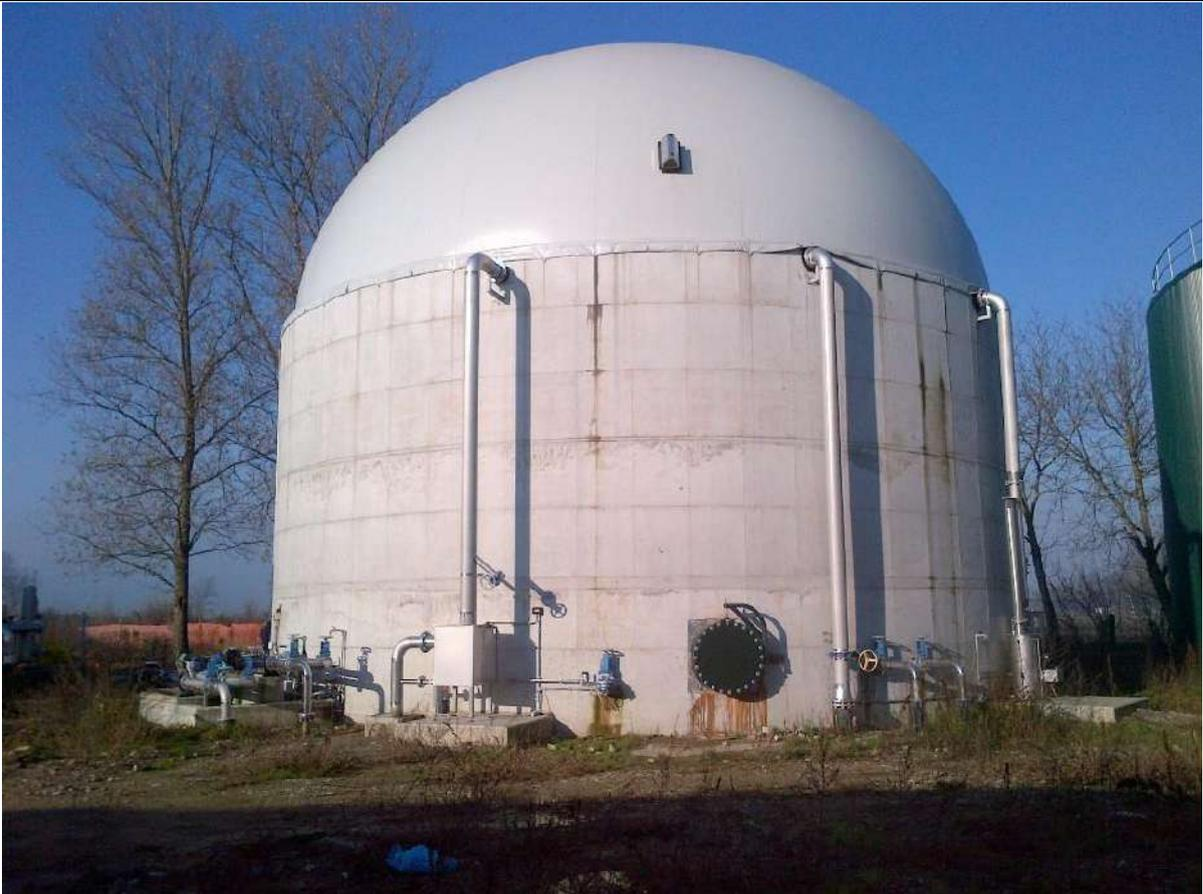
**Figura 1.2.5.c - Esempio di digestore freddo e copertura gasometrica.**
