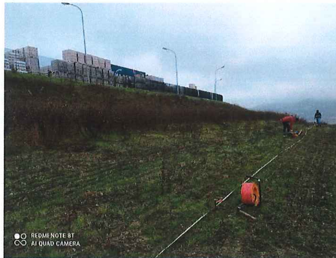
Indagine geoelettrica SEV1
