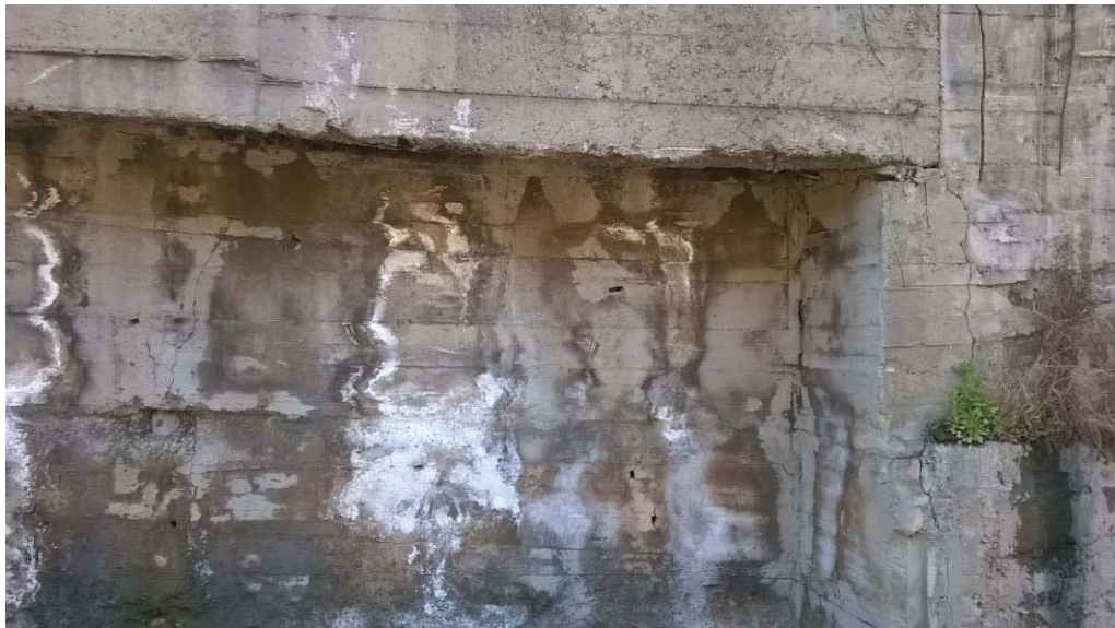
Muro di sostegno confine Est area aziendale Stato di fatto in periodo non piovoso
