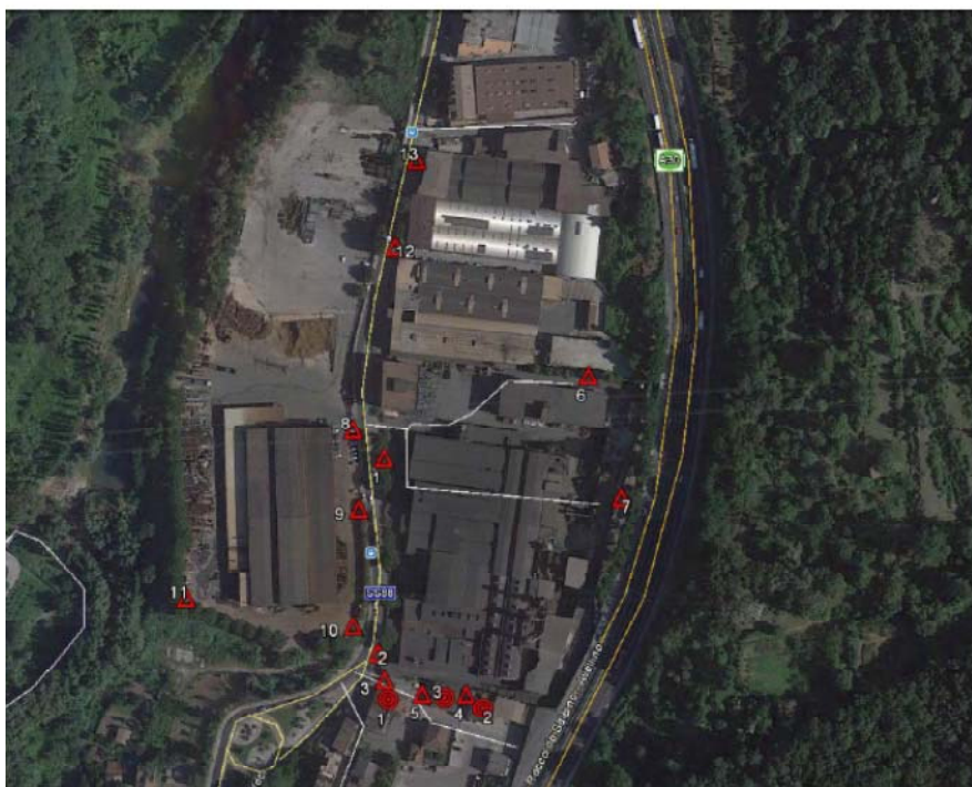
Figura 4.47 - Indicazione dei punti di misura del rumore ambientale (Relazione redatta dal dott. M. Giordano)
