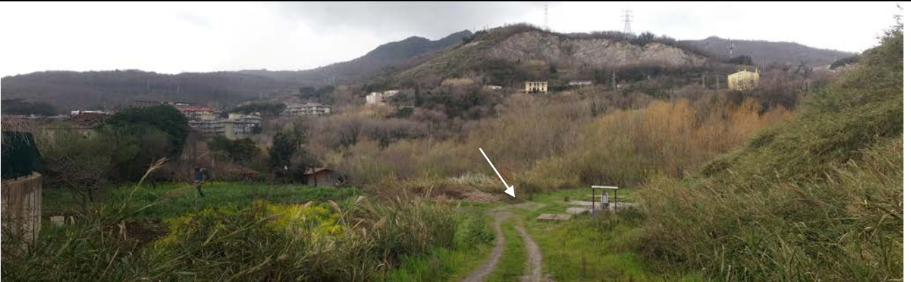
Foto 1: si evidenzia il contesto in cui si inserisce l'opera oggetto di intervento; si intravede la vasca esistente. La freccia indica l'ubicazione della nuova vasca
