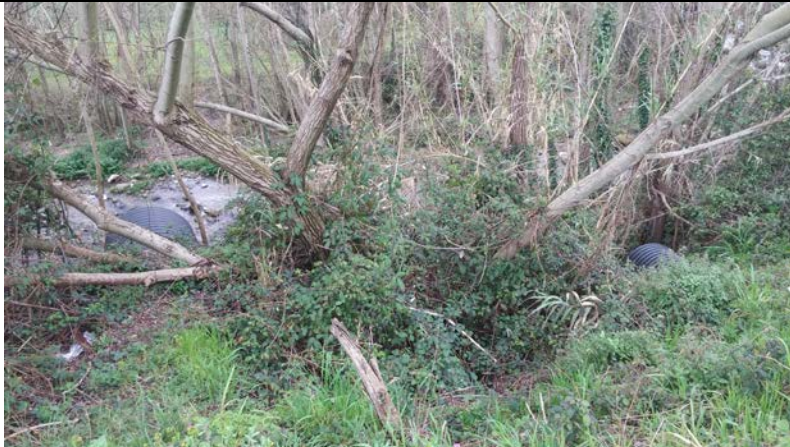
Foto 4: si evidenziano in foto gli scarichi esistenti; quello a destra verrà eliminato; verrà inserito un nuovo scarico rappresentante il troppo pieno della vasca. Si sottolinea che si provvederà ad un miglior camouflage degli stessi
