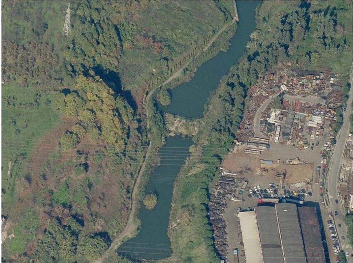
Figura 4.3 - Foto aerea del fiume Irno. Dettaglio di alcune aree dove l'alveo si allarga.
