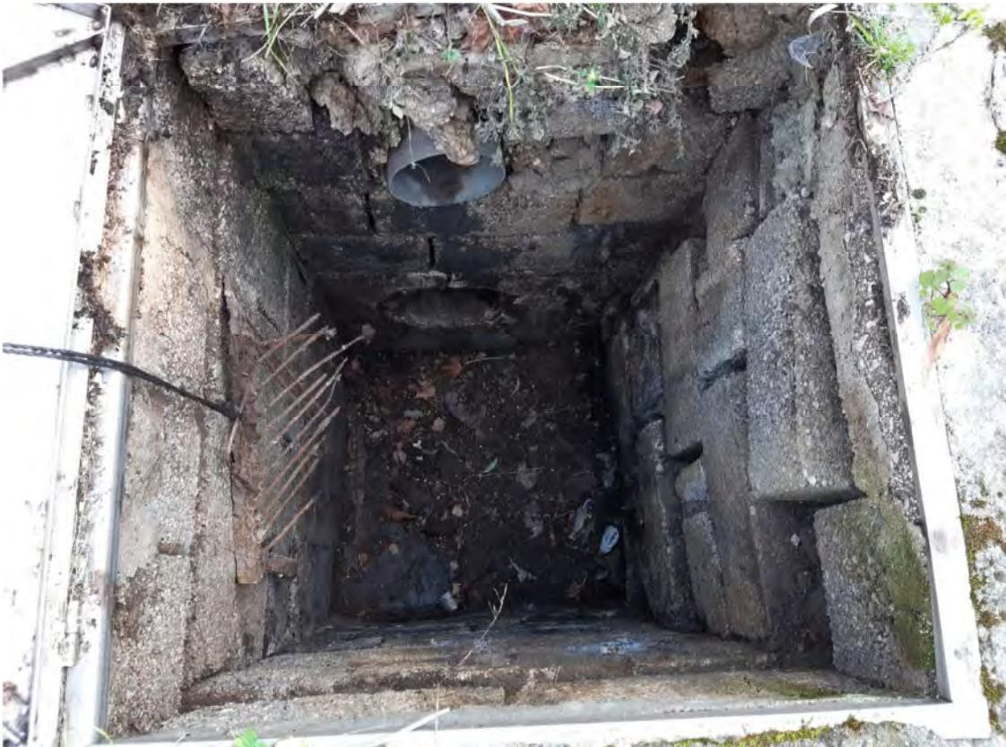
*Figura 4 - pozzetto di raccolta dimensioni 80x80*
