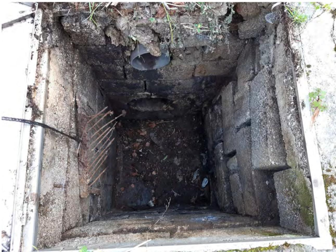
*Figura 9 - pozzetto di confluenza delle acque da trattare verso le vasche di trattamento*
