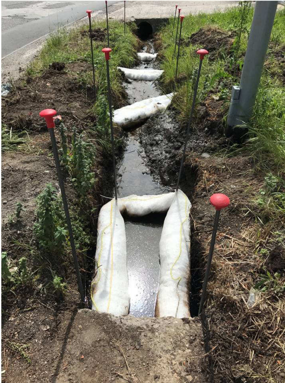
Foto 2 – Intervento di MISE con posizionamento dei primi pannelli oleoassorbenti
