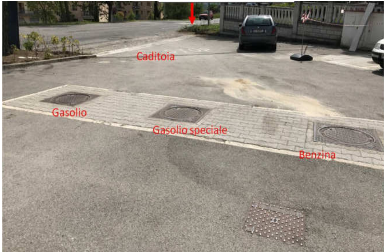
Foto 1 – Ubicazione Serbatoi e Fosso
