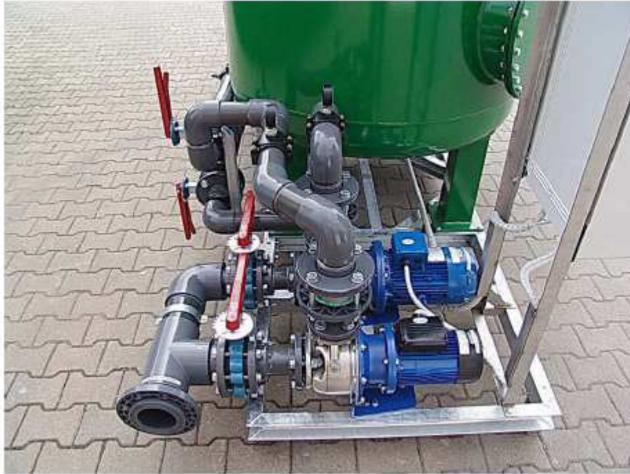
Particolare stazione di pompaggio
