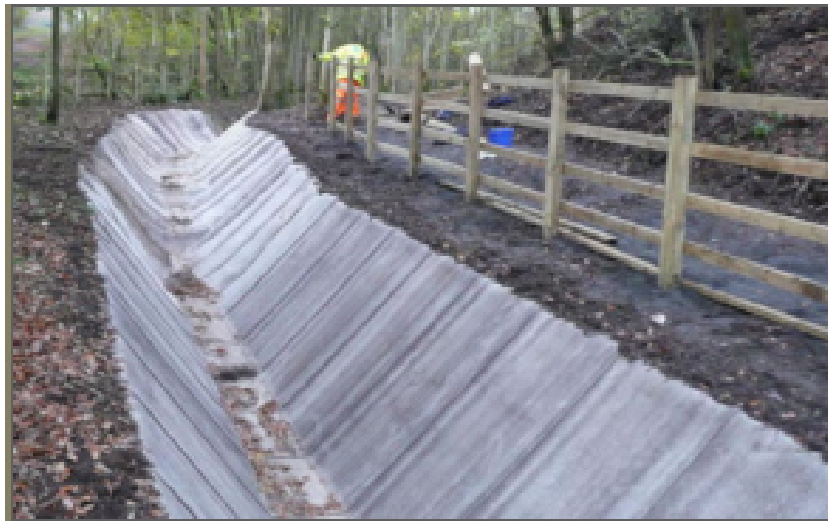
Figura 6-1 Esempio applicativo dell'utilizzo di geocanvas per l'impermeabilizzazione di canali e fossi
