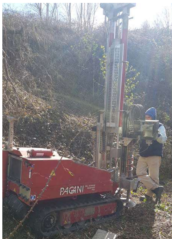
Particolare del sondaggio DPSH1 (13/03/2019)
