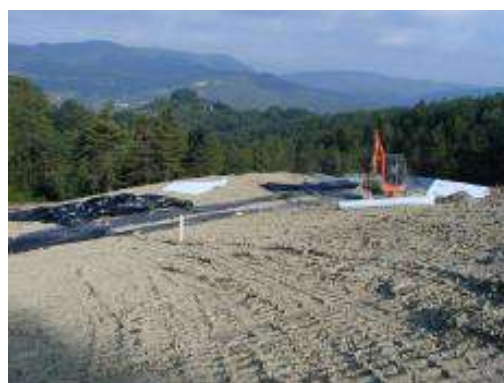
La posa in opera della geomembrana HDPE e dello strato di argilla
