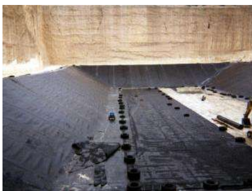
La posa in opera della geomembrana HDPE e dello strato di argilla
