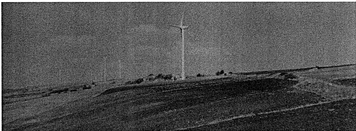
Fig. 61 – Località Case Russe, panoramica del sito 74
