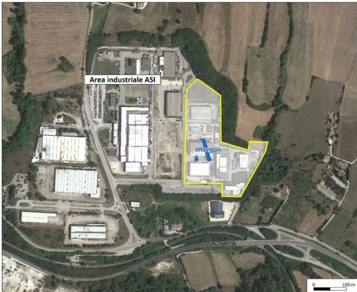
Figura 1 - Vista dello stabilimento Altergon con individuazione dell'area oggetto di intervento
