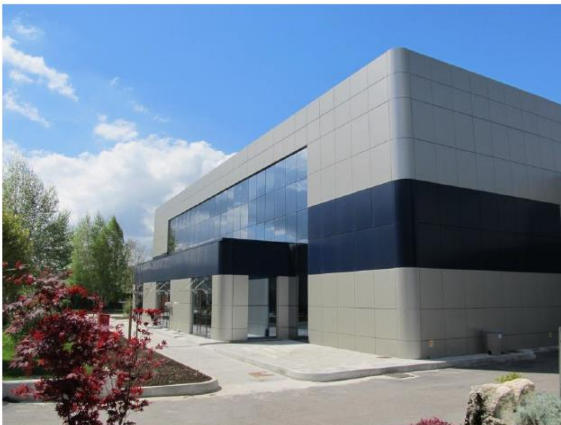
Figura 3 - Particolare edificio interno allo stabilimento Altergon
