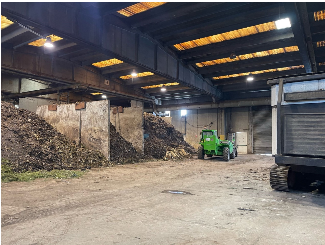
FOTO 4 – Eco-Resolution Srl, vista panoramica linea A zona di rivoltamento e maturazione compost, interno capannone B.
