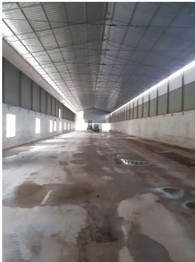
Foto 2 – Capannone in fase di allevamento all’atto della verifica ispettiva
