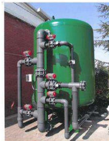
Esempio di filtro su skid
