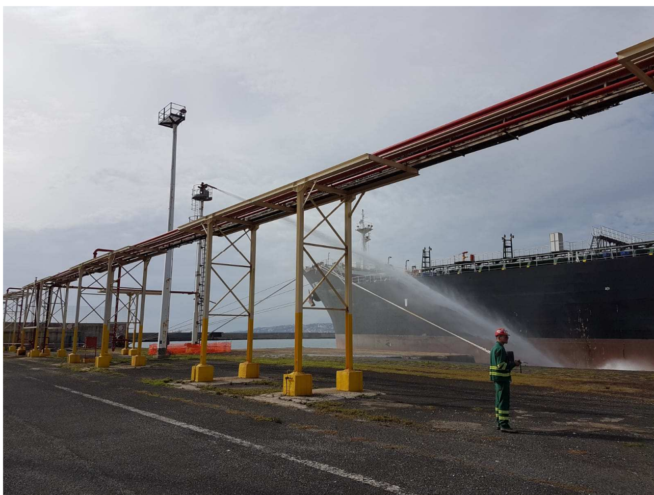
Figura 2.5.1 – Fasi di prova impianto idrico antincendio
